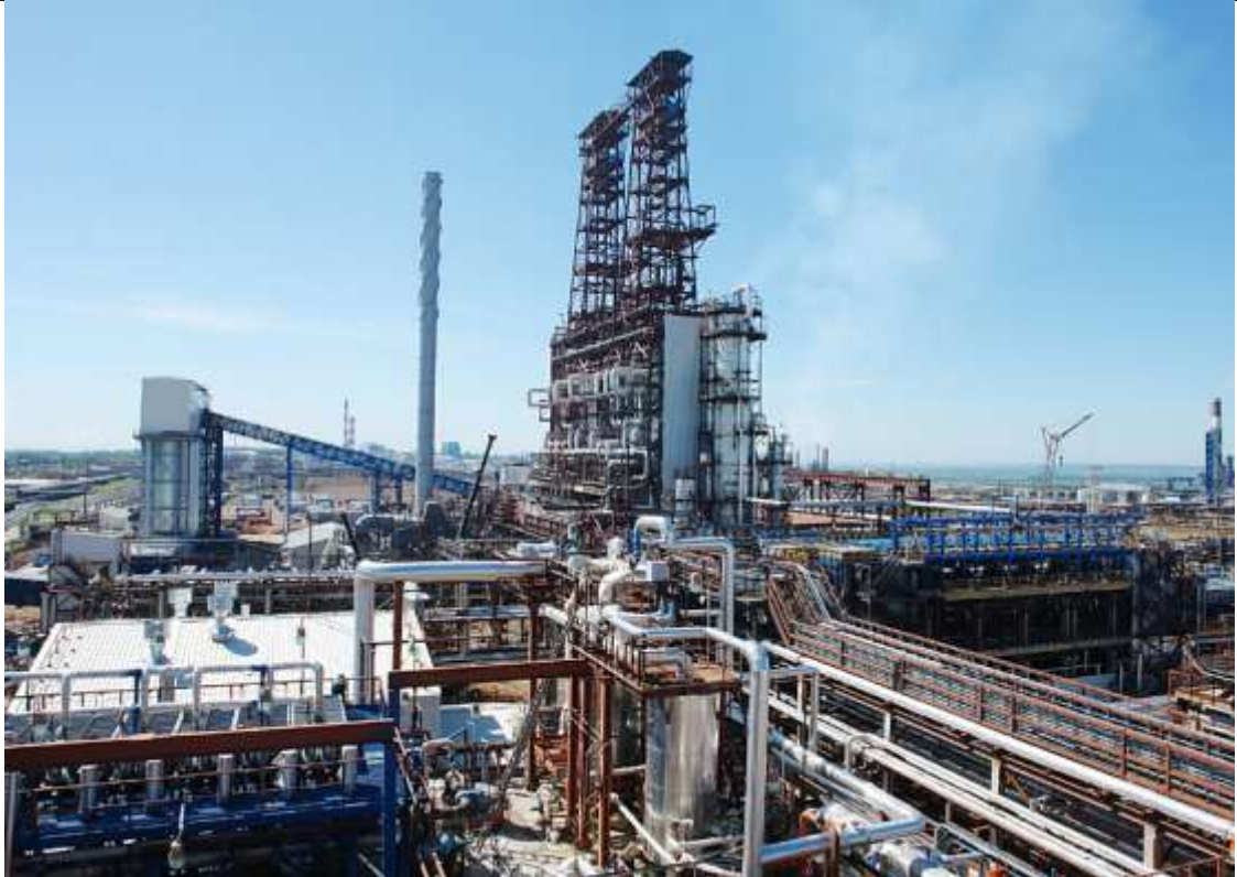
Установка по производству серы.
